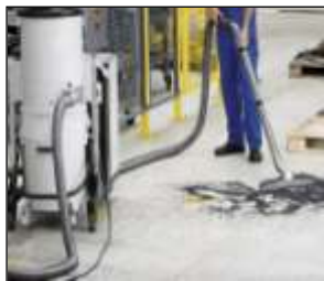
地面打磨处理
